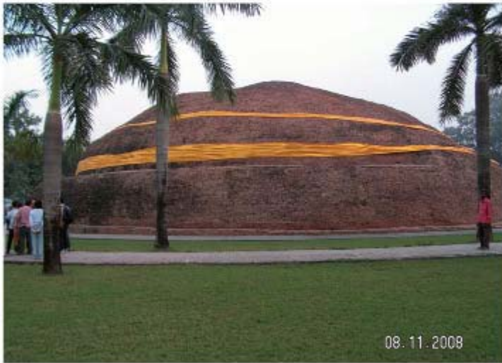
Hình 30: Đây là Tháp Makkhali Gandhara (Hóa Tàng) được người bộ tộc Malla xây dựng lên ở ngay nơi nhục thân Đức Phật được hỏa táng. Tháp bao gồm một khối trụ tròn có đường kính 34m nằm trên một nền móng tròn có đường kính 47m. Tháp này không có thờ và lợi Phật.
