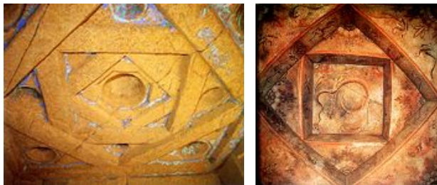
Pic 16. 아프간 바미안 석굴의 733굴(窟)의 궁륭형천장 좌와 고구려 고분속의 궁륭형 천장(북한 남포시 삼묘리 소재 강서작은무덤)
