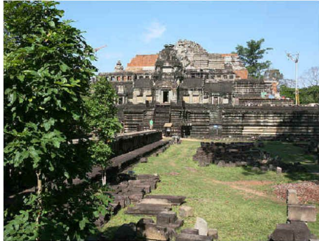
그림 3. 프랑스팀이 복원 중인 바푸온 사원 전경
